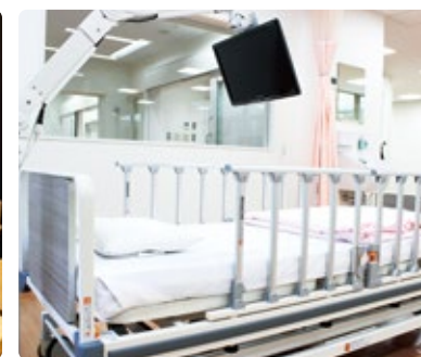
B 人工腎臓部透析ベッド 映像サービス設置(中央診療棟3F)
