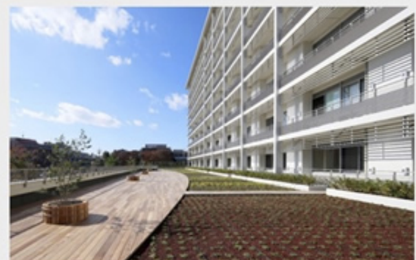
南側の屋上庭園
